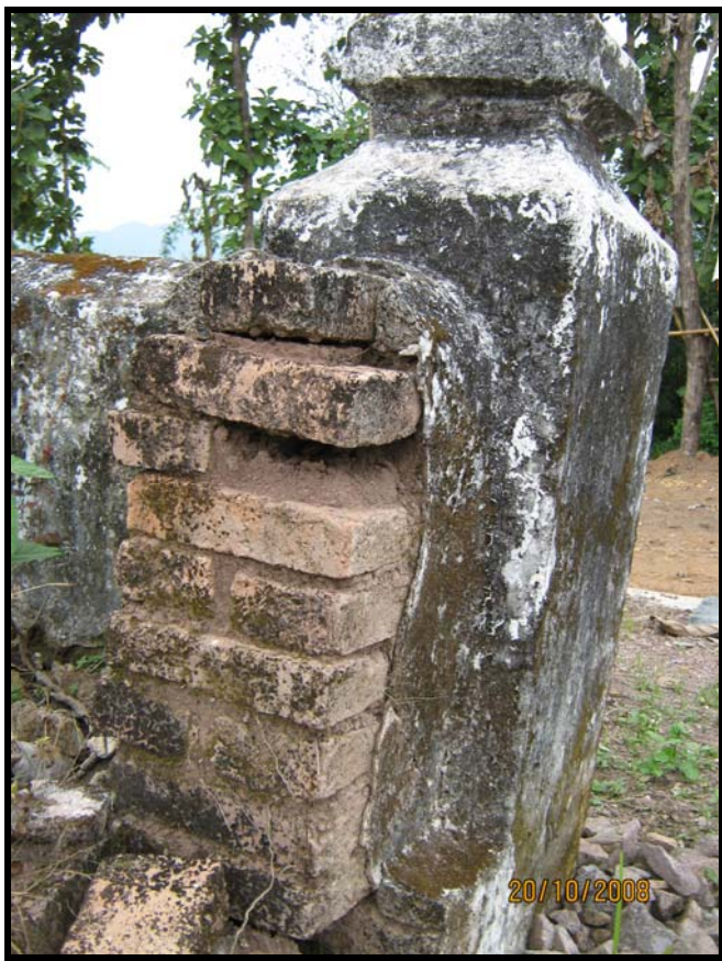
ลักษณะการชำรุดของกำแพงล้อมองค์พระธาตุ ควรให้เจ้าหน้าที่ตรวจสอบและบูรณะ
