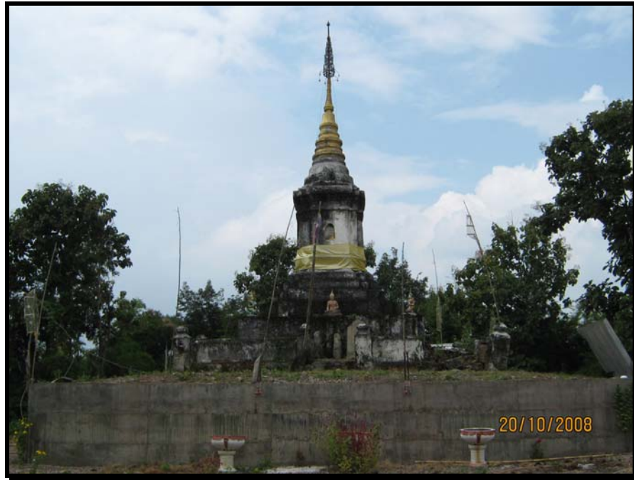
สภาพองค์พระธาตุคอยโตน ที่มีการปรับแนวดินใหม่และเสริมฐานรากอีกชั้นหนึ่ง
